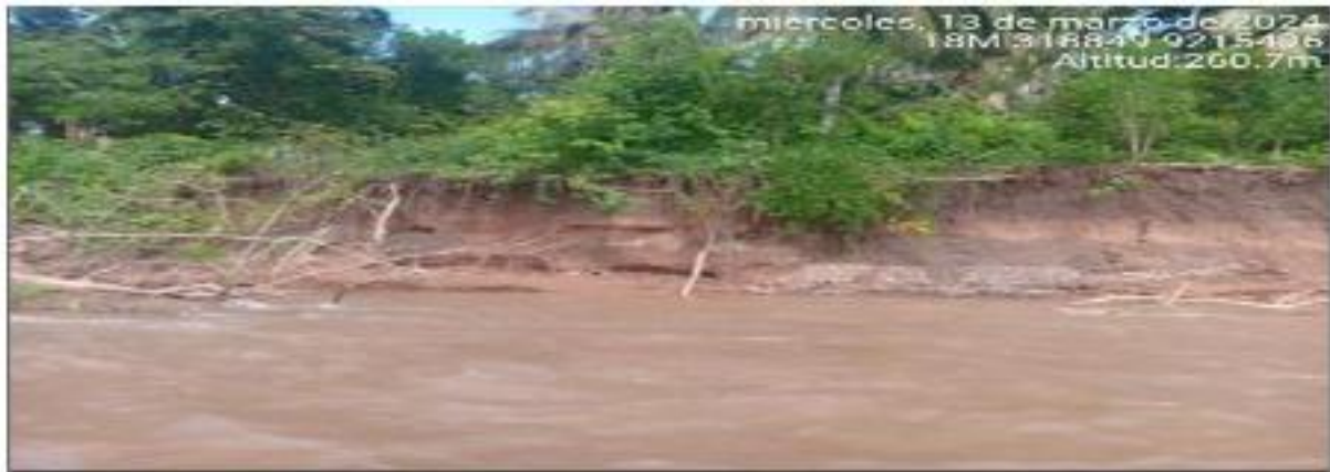
FIGURA N°01: TRAMO CRÍTICO EN EL RIO HUALLAGA, SECTOR TINGO DE SAPOSOA, DONDE SE OBSERVA LA EROSION Y SOCAVAMIENTO DEL TALUD DE LA RIBERA, GENERANDO DESPLOME.
