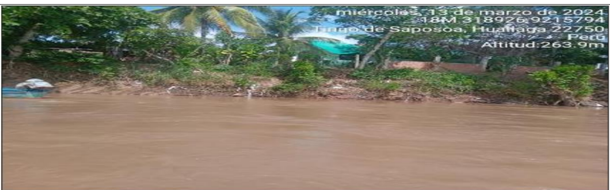
FIGURA N°02: TRAMO CRÍTICO EN EL RIO HUALLAGA CON BORDOS BAJOS, ES POR DONDE OCURRE EL DESBORDE OCASIONANDO LA INUNDACION.
